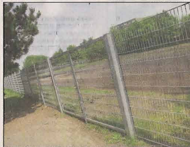
Seit einem Jahr von der Schulleitung wegen Verletzungsgefahr geschlossen: der Tartanplatz der Gesamtschule am Krusenhof.
